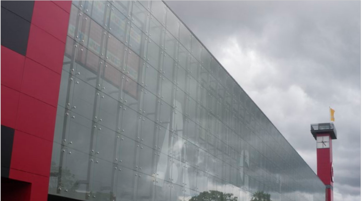
Astri kaubanduskeskus, Narva - fassaadi punktkinnitused ja spider-tarvikud
